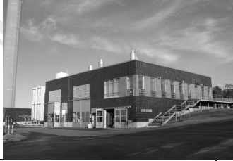
Henriksdals vattenreningsverk, Stockholm
